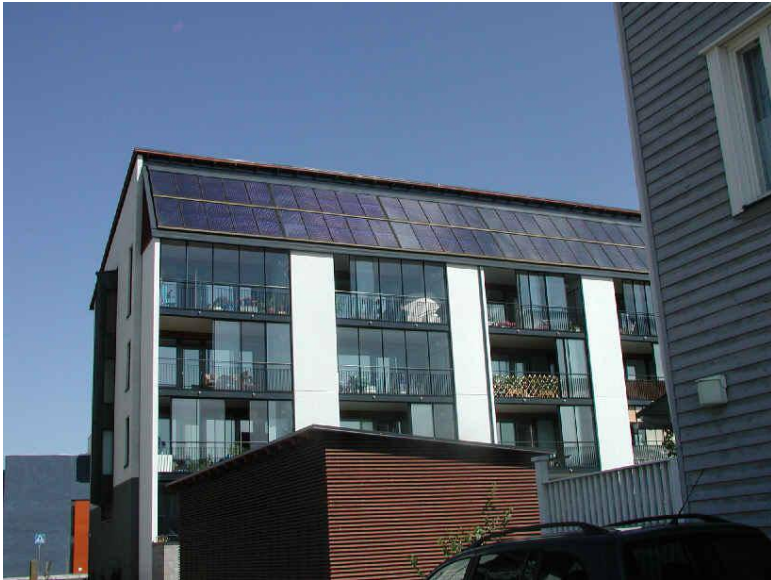
Eko-Viikki: aurinkolämpöjärjestelmä
