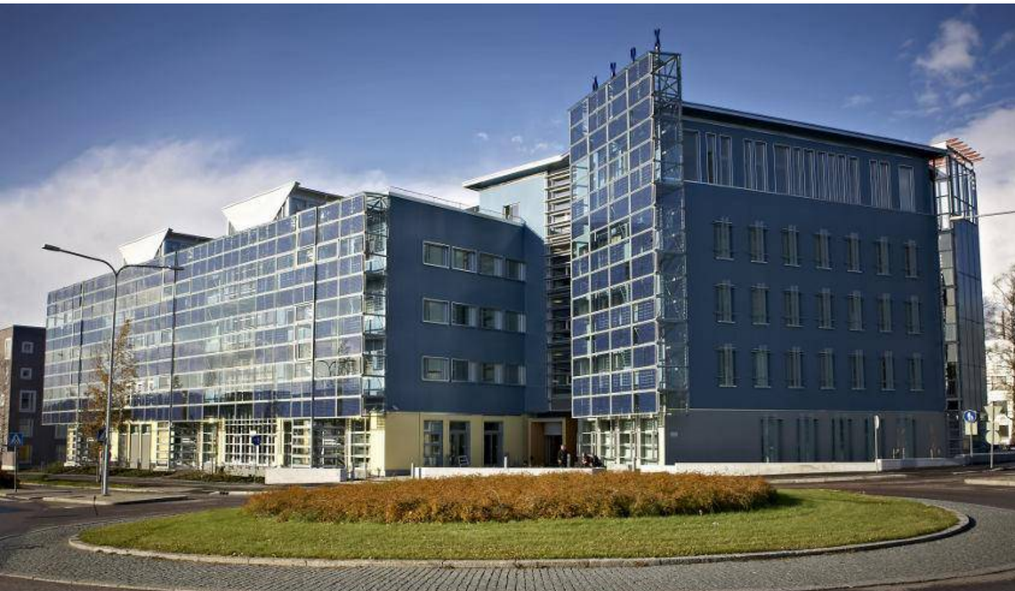
PV-paneelit julkisivun varjostavana elementtinä, Viikin Ympäristötalo
