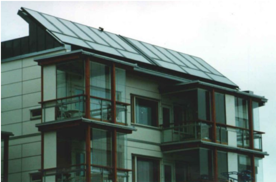
Eko-Viikki: modulaariset tasokeräimet 45° asennuskulmassa
