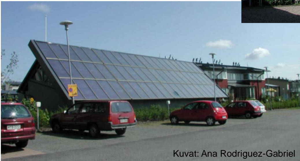
Eko-Viikki: aurinkolämpöjärjestelmä
